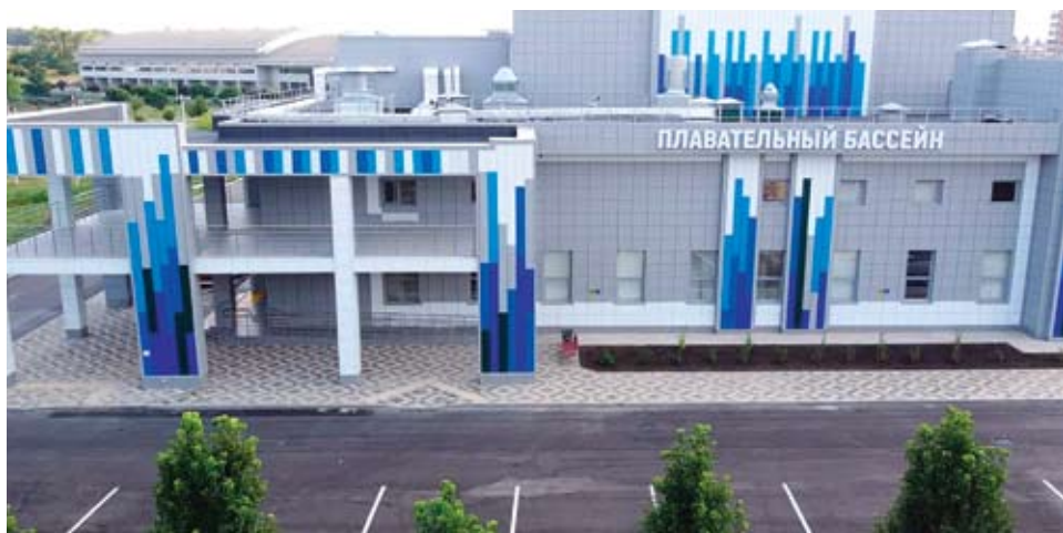
Строительство бассейна завершилось в июне 2021 года. Здание, общей площадью – 3526,29 кв. м, оборудовано современными системами вентиляции и кондиционирования
